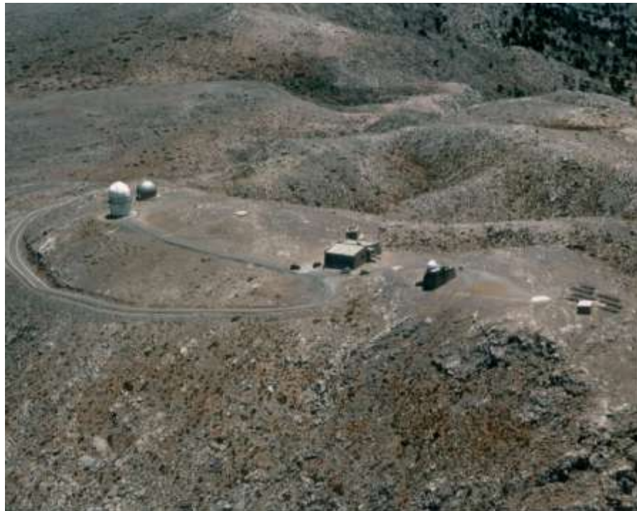
Σχήμα 2.1: Αεροφωτογραφία του Αστεροσκοπείου του Σκίνακα. Στο κέντρο της εικόνας βλέπουμε τον ξενώνα, αριστερά του (ο θόλος με το λευκό χρώμα) βρίσκεται το 1.3m τηλεσκόπιο, ενώ δεξιά του το 30cm τηλεσκόπιο.
